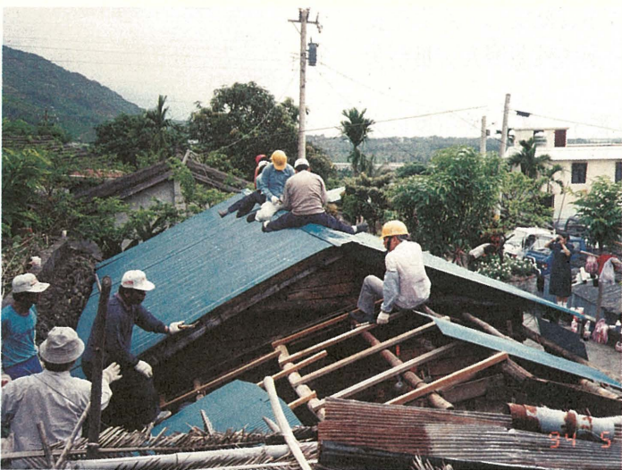
臺東慈濟人為老原住民腐朽的屋頂，換上全新的鐵皮浪板；往後屋內再也不會漏雨了。
