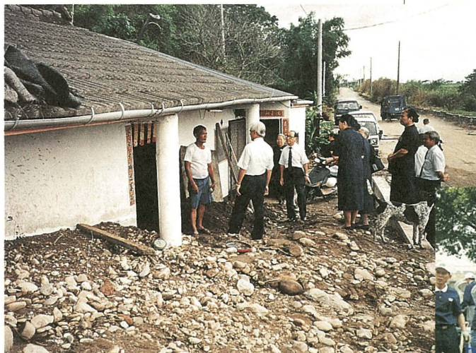
台東縣池上鄉新開圖一民宅遭土石流自屋後淹沒，慈濟人致贈慰問金並勘察災情以評估後續援助。
