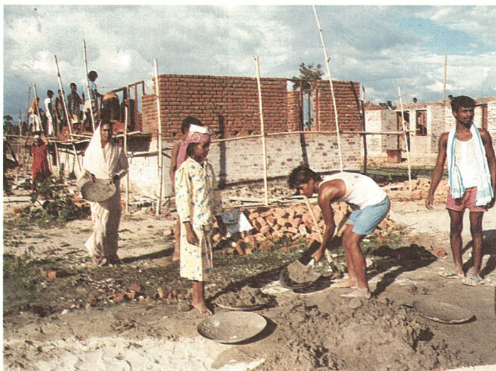
慈濟為尼泊爾水患災民興建的「愛心屋」，不僅工程品質良好，進度亦超前。
