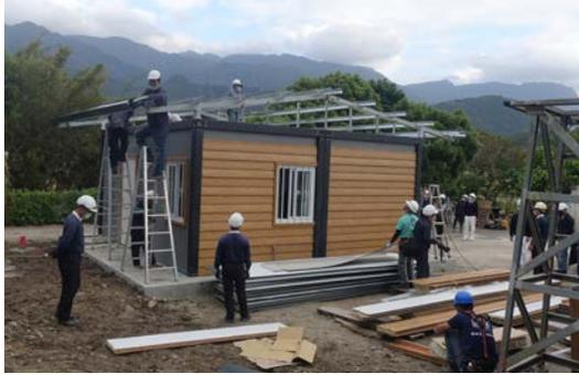
鋼構安心屋的屋頂加架斜板，能避免下雨時的吵鬧聲，炙熱的陽光也不會傳導至室內，讓住戶有舒適的居住環境。
