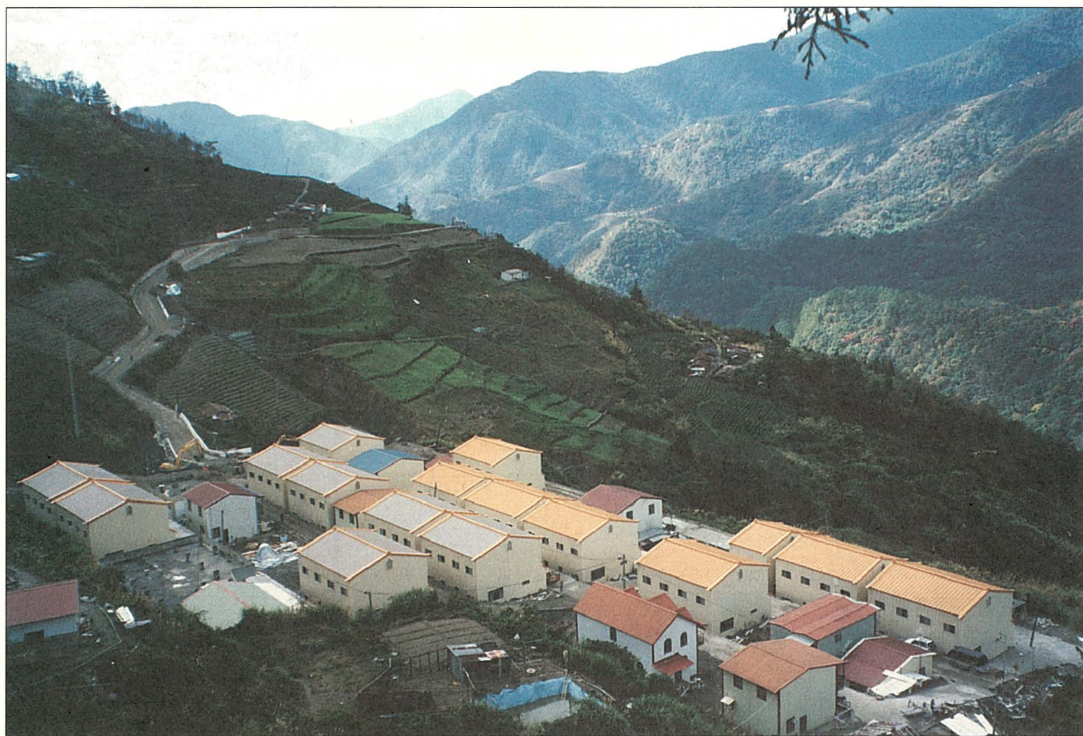
南投仁愛鄉力行村翠巒部落重建工程已近尾聲，預計明年二月前可將三十一幢慈濟屋交到泰雅居民手中。
