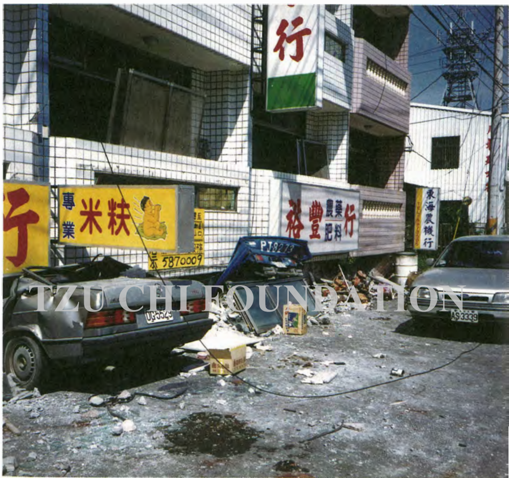
雲林縣整排建築物下陷坍塌，並壓毀停在路旁的車輛。
