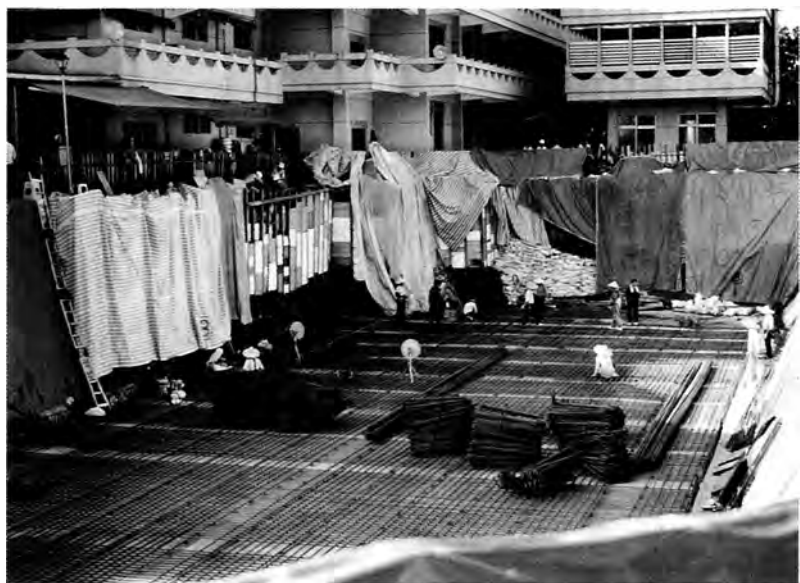
◎鋪滿塑膠布的地下室
