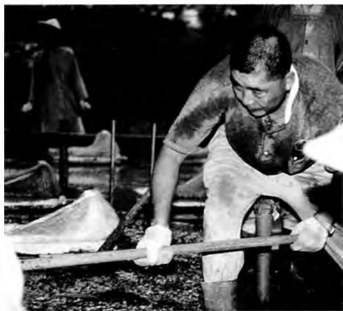
◎除了水電裝設外 林師兄亦 投入其他 工項
