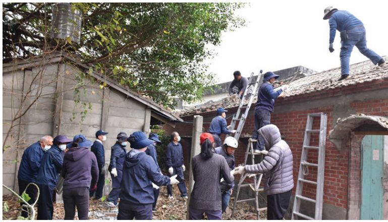
▲慈濟志工有默契地以人力接龍方式，拆除破舊的瓦片，更換成新瓦。（攝影：蔡宜達）
