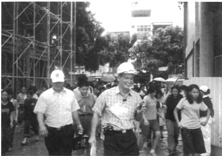
九二一希望工程援建，災峰國小校長許昆龍戴著安全帽巡查工程。照片／慈濟草屯聯絡處提供
