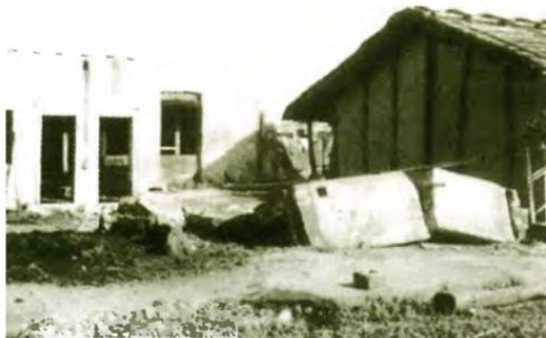
台東縣新港(成功鎮)水泥礫石建造之民房，地震時向北—西方向傾倒。(徐鐵良先生、林明聖博士提供)
