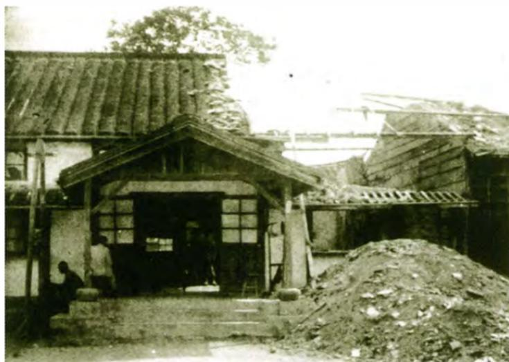
南投廳埔里社支廳（南投縣埔里鎮）廳舍（土塙厝），屋頂及土塙壁倒塌過半。
