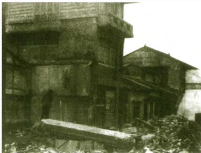
台南縣新化鎮護國里鋼筋水泥之三層建築物倒毀，柱子向南八十度西折斷。(陳培源教授提供)
