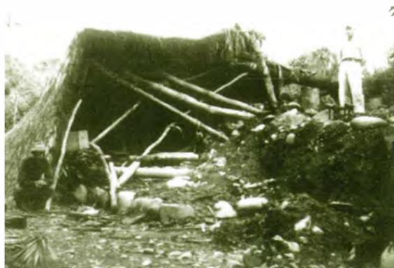
玉里斷層露頭，位於斷層線上的民房傾塌，斷層東側地塊至少上升一公尺。(鄭世楠博士提供)
