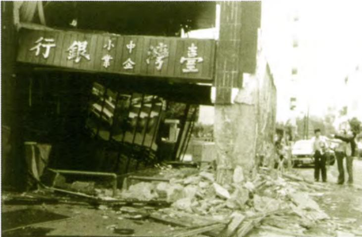
台北市復興南路一段某大廈，牆腳被壓碎，鋼筋暴露變形，牆面呈剪力龜裂，一、二樓間之樓板下陷；外部鋁門窗扭曲變形。（溫國樑博士提供）
