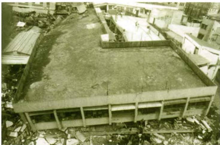
台北縣中和市員山路的華陽市場，為三層多柱少牆的鋼筋水泥建築，因支柱折斷，造成一二樓坍塌，形成「三明治」型破壞，造成十二人死亡、數十人受傷的慘劇。
