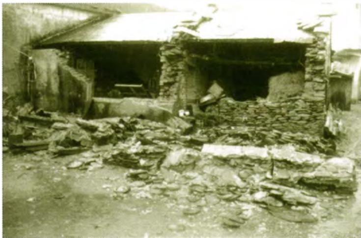
宜蘭縣蘇澳鎮震災較新式的磚造牆（圖左）與傳統的頁岩疊砌之牆（圖右）皆潰倒。
