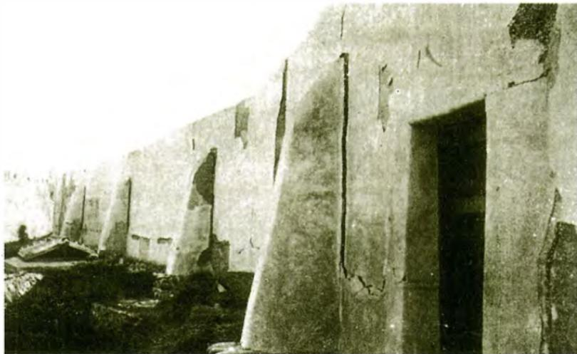
台南監獄嘉義支監（嘉義市）北側牆壁之裂隙；其土牆高四點五公尺、厚六十三公分。（鄭世楠博士提供）
