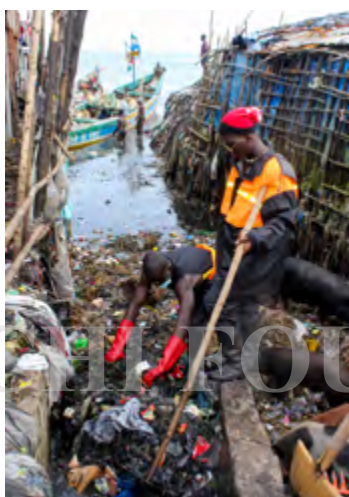
參與以工代賑計畫民眾清理蘇珊灣出海口的溝渠，只見垃圾塞滿水溝，當地居民還以垃圾為地基在一旁搭建起房屋。圖片／慈濟基金會提供
