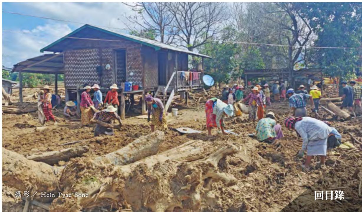
交通進出；慈濟志工決議為其鋪路，租用挖土機投入工程，並動員鄉親將路面石塊、殘木清除，製作竹筋及沙包以鞏固地基，讓村民及徒步上學的孩子們有安全的道路。
