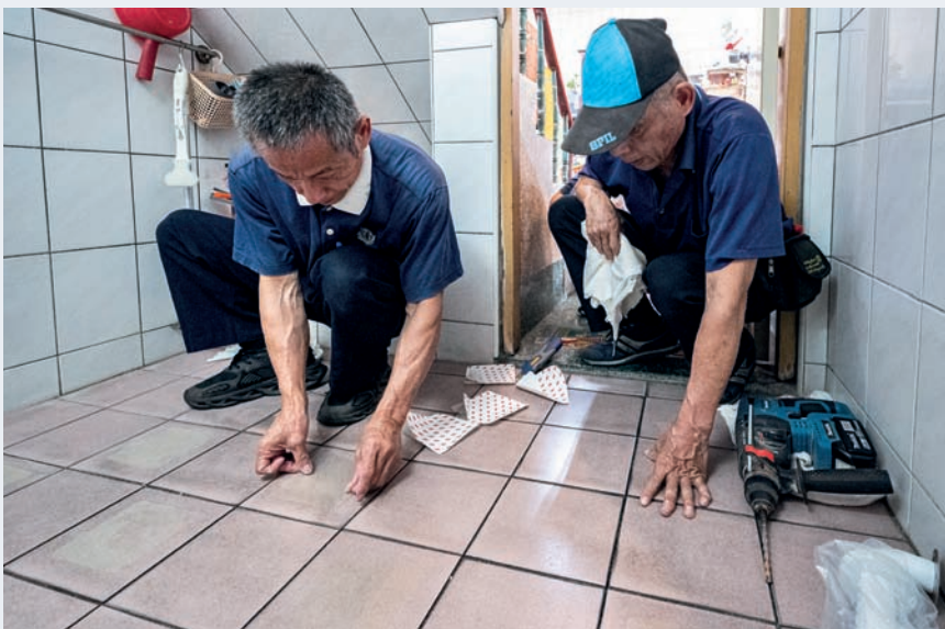
慈濟修繕志工在申請者浴室地板貼透明的防滑貼片，止滑措施是居家安全改善重點之一。
